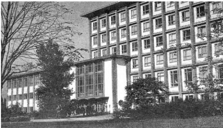
Institut für Kerntechnik Dresden, 1. Anwendung des Vakuumbetonverfahrens für Stahlbetontragwerke Planung: H. Stoll – IPRO Dresden, Fertigstellung: 1965
