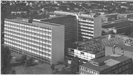
BASF Laboratoriumsbauten der Anwendungstechnik, Ludwigshafen am Rhein. Die großformatigen Stahl- beton-Deckenfertigteile wurden in einer Feldfabrik an der Baustelle hergestellt und mit Portalkränen montiert Planung: Prof. Dr.-Ing. H. Hentrich und Dipl.-Ing. H. Petschnigg, Fertigstellung 1963
