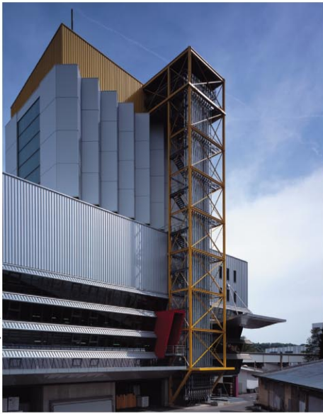
Produktionsanlagen StoSilo Tower und Service Fabrik Planung: Wilford Schupp Architekten, Fertigstellung: 2003
